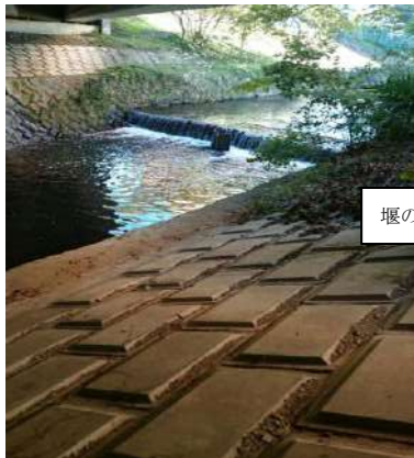
軒吉橋付近 新幹線下の堰
