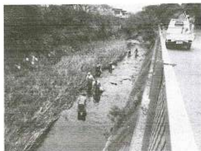
清掃作業 塩海橋～下浜橋間
