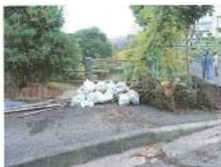
11 月 8 日 今日のゴミ 西谷戸橋に集荷 蛇籠使用の肩鉄の引き上げが一苦労
