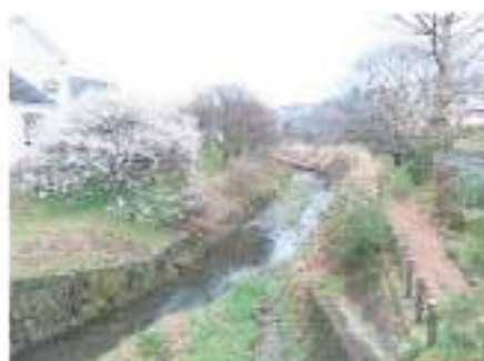
平成 27 年 3 月 7 日 降雨の為清掃中止 新西谷戸橋～清水橋間清掃予定でした。
