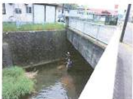
平成 26 年 5 月 3 日 清掃区間 前田橋～新西谷戸橋間
