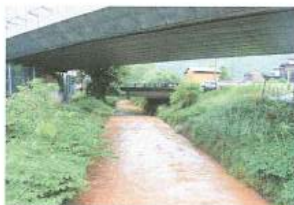
6月7日増水した葛川・軒吉橋上流にて 雨天、増水、作業中止
