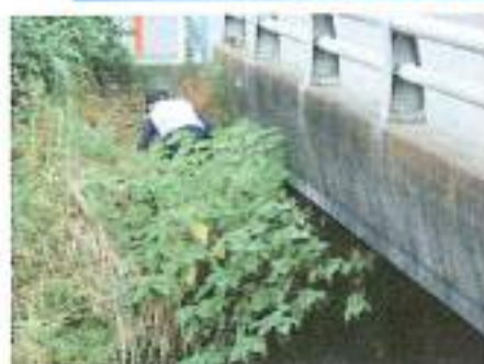
平成 26 年 7 月 19 日清掃区間 妙見橋～花月橋間 梯子を設置するため草刈り
