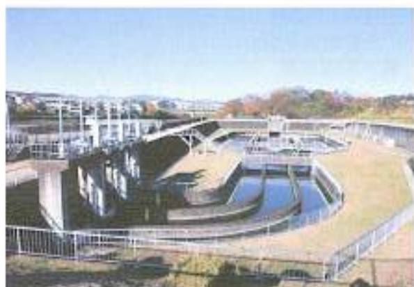
玉川用水取り入れ口の少し上流にある羽村堰
