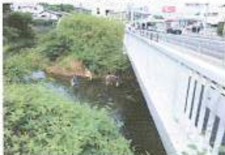
平成27年7月18日こゆるぎ橋でゴミ引上げ
