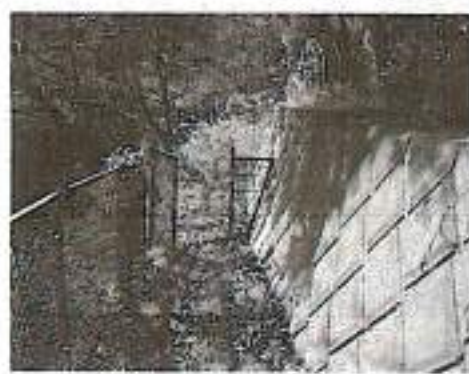
下浜橋上流フェンスの縦借用 (平塚土木事務所ヨリ) 川中に降りるに非常に助かる
