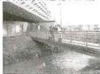
軒吉橋上流新幹線下
