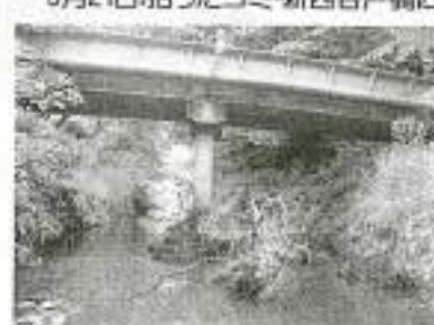
6月18日貝が塚橋、橋桁に貯まった流木、努力したが50%の除去 「神奈川県平塚土木事務所」に連絡し除去してもらった。
