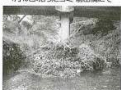
6月18日貝が塚橋、橋桁に貯まった流木、努力したが50%の除去 「神奈川県平塚土木事務所」に連絡し除去してもらった。
